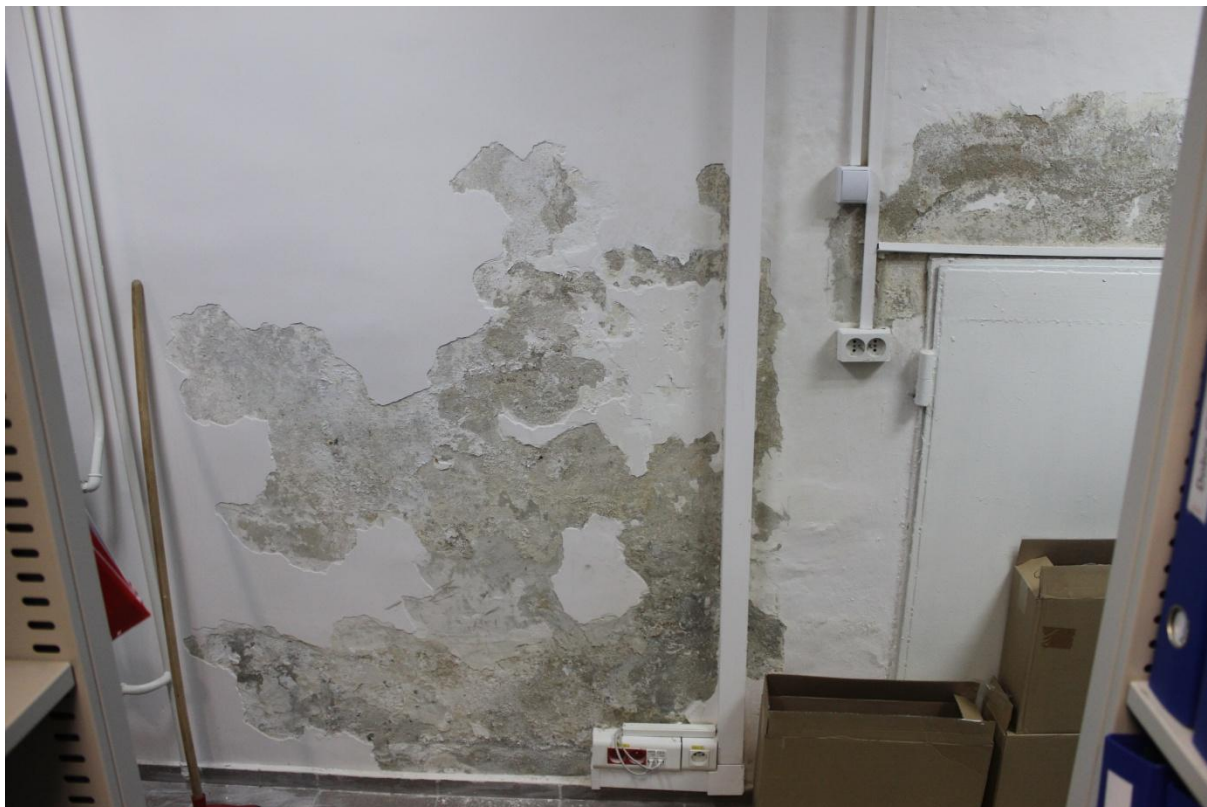
Fotografia 6. Ściana S-W w piwnicy. Widoczne zasolenie ściany oraz silne zawilgocenie, uszkodzenie tynku oraz powłok malarskich.
