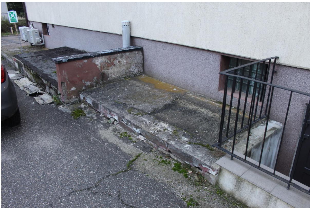
Fotografia 7. Ściana S-W widziana od strony zewnętrznej. Widoczne uszkodzenia konstrukcji murowej i żelbetowej oraz zużycie techniczne i nieszczelność izolacji.
