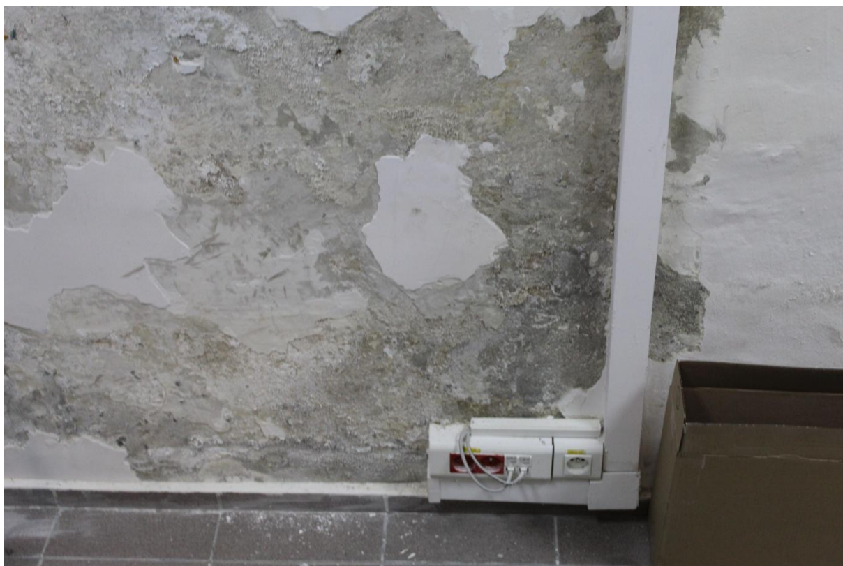
Fotografia 5. Ściana S-W w piwnicy. Widoczne zasolenie ściany oraz silne zawilgocenie, uszkodzenie tynku oraz powłok malarskich.
