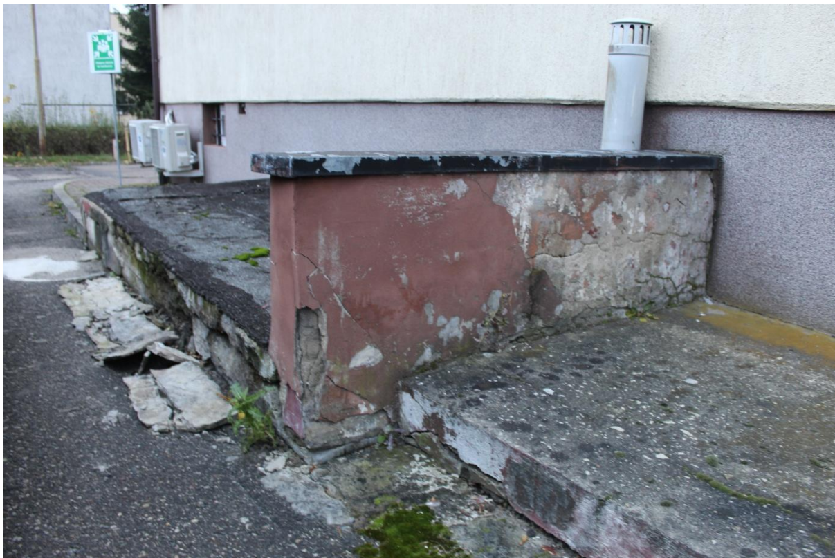
Fotografia 8. Ściana S-W widziana od strony zewnętrznej. Widoczne uszkodzenia konstrukcji murowej i żelbetowej oraz zużycie techniczne i nieszczelność izolacji.
