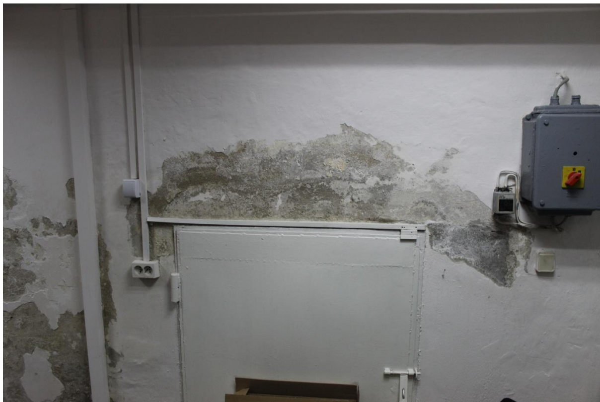
Fotografia 3. Ściana S-W w piwnicy. Widoczne zasolenie ściany oraz silne zawilgocenie, uszkodzenie tynku oraz powłok malarskich.
