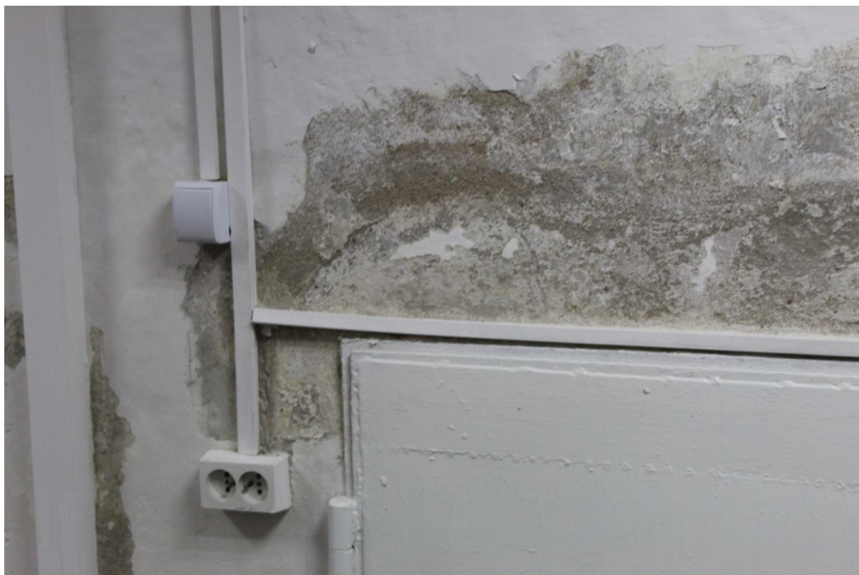
Fotografia 4. Ściana S-W w piwnicy. Widoczne zasolenie ściany oraz silne zawilgocenie, uszkodzenie tynku oraz powłok malarskich.
