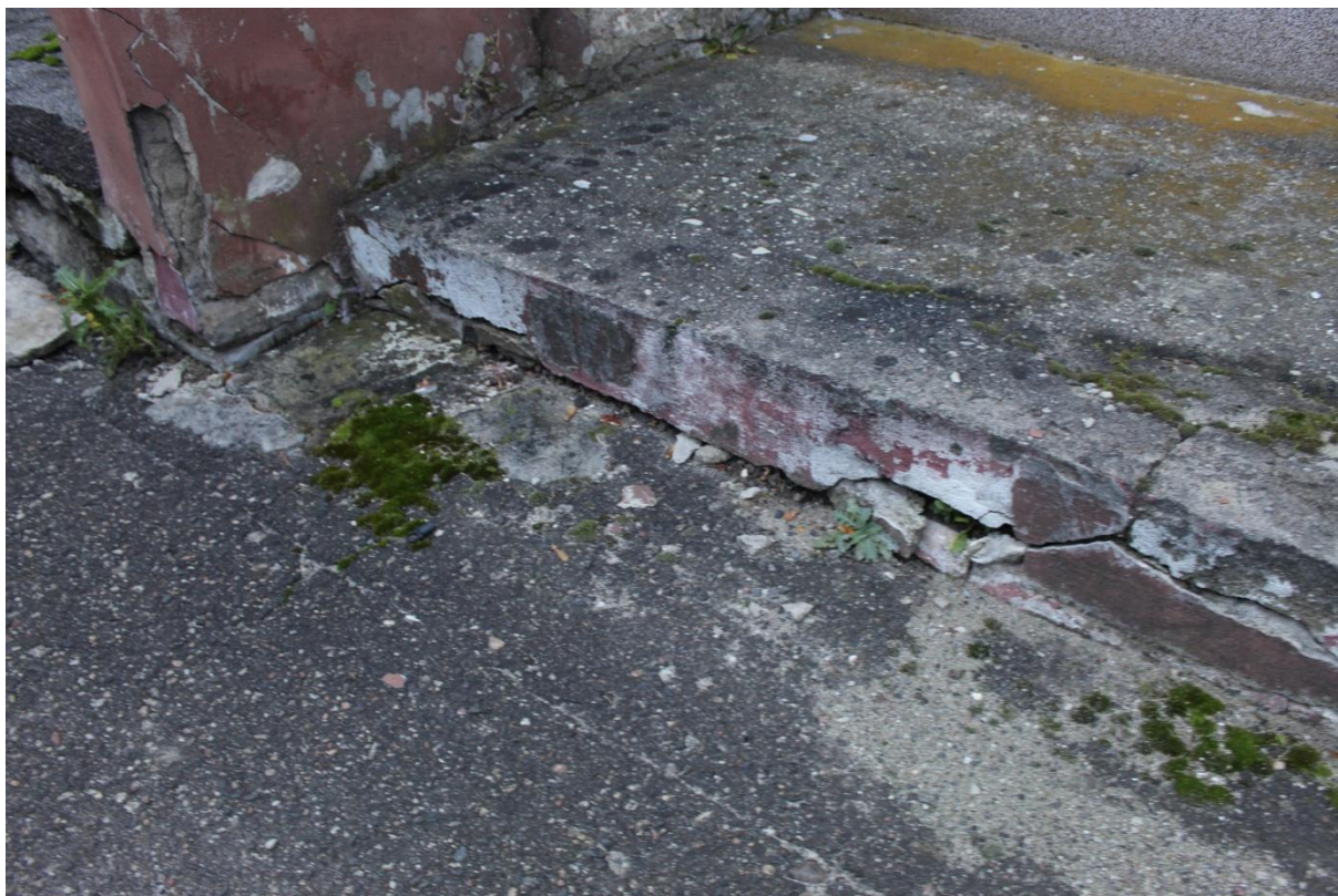
Fotografia 9. Ściana S-W widziana od strony zewnętrznej. Widoczne uszkodzenia konstrukcji murowej i żelbetowej oraz zużycie techniczne i nieszczelność izolacji.
